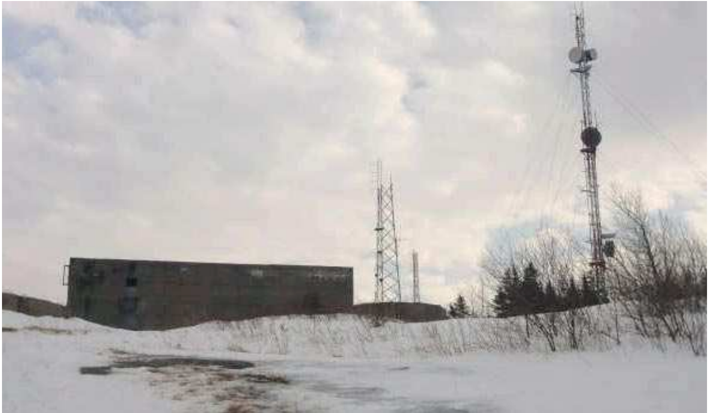
Témoignage du passé militaire du site, l'ancien bunker situé au sommet de la montagne abritait un radar chargé de surveiller l'espace aérien de la région
